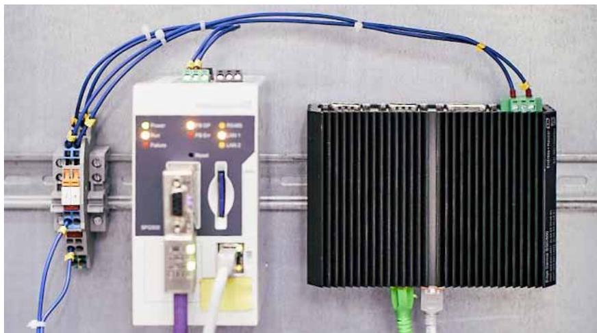
**Realización** Unos empleados de Salzgitter Flachstahl GmbH instalaron la pasarela de red Ethernet/PROFIBUS SFG500 y un equipo Edge Device conectado directamente a Internet en la red PROFIBUS. Tanto la pasarela de red como Edge Device proporcionan la conectividad entre IT y OT y hacen un escaneo automático de la planta en busca de todos los equipos de medición, independientemente de si son de Endress+Hauser o de otros fabricantes.
